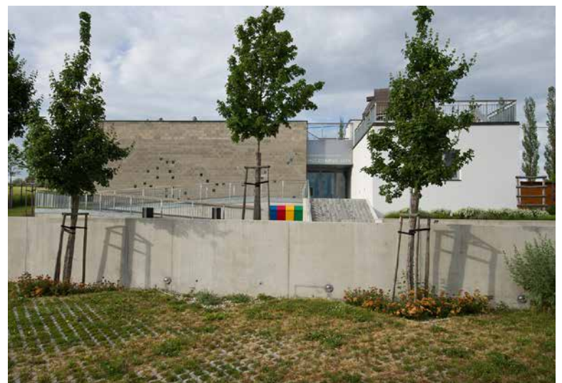
↑ Krčok je nižší než prístavba i pôvodná budova, čím vyrovnáva ich rôzne výškové úrovne.
