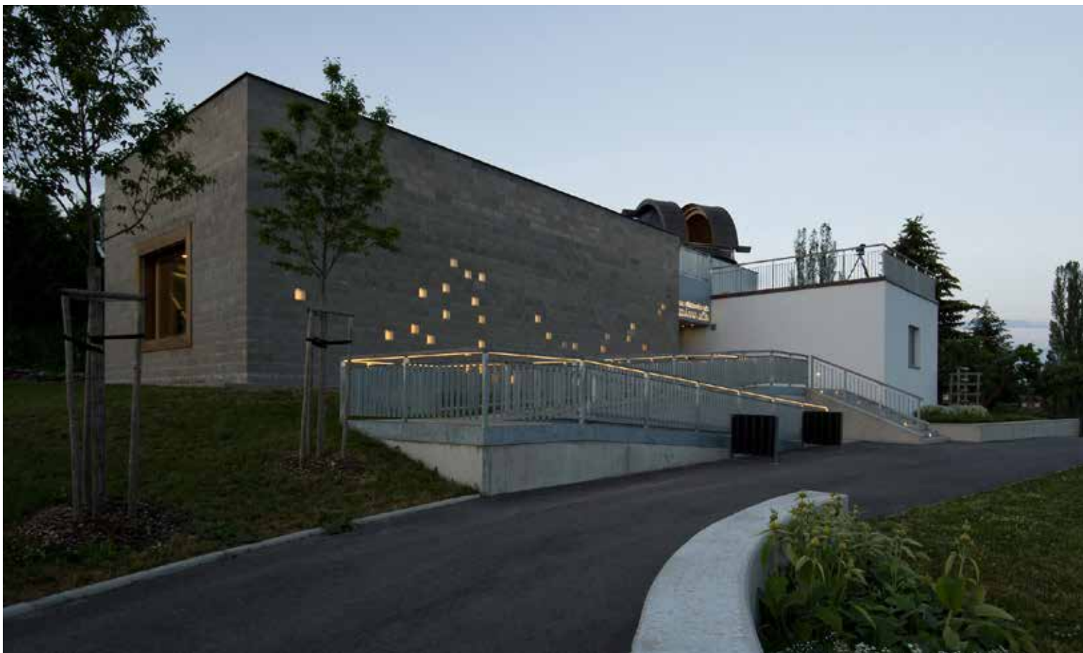
↑ Souhvězdí na fasádě pouští přes den do interiéru světlo, večer láká kolemjdoucí dovnitř.
