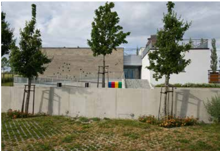
↑ Krček je nižší než přístavba i stávající budova, čímž vyrovnává jejich různé výškové úrovně.
